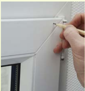
Abb. 14: Position der Bohrung für die Umlenk-Rolle markieren
