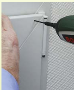
Abb. 15: Vorbohren für die Befestigung der Umlenk-Rolle
