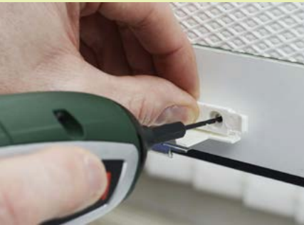
Abb. 6: Löcher am Fensterrahmen vorbohren
