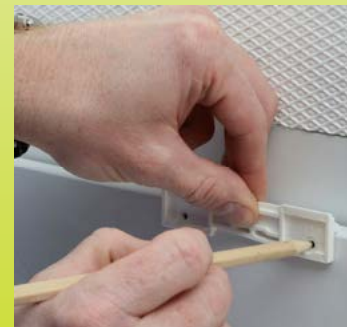
Abb. 1: Fensterflügel-Halterung (C) anlegen und Bohrlöcher anzeichnen
