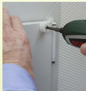
Abb. 16: Anschrauben der Umlenk-Rolle
