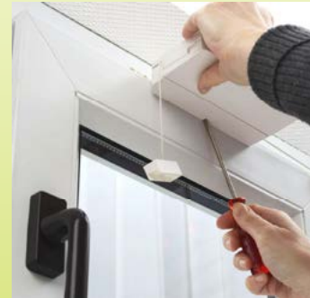
Abb. 43: Einrastung lösen
