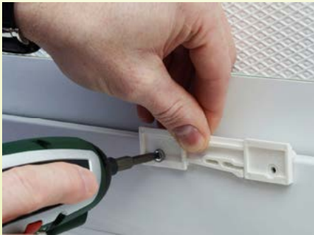
Abb. 3: Schrauben am Fensterflügel
