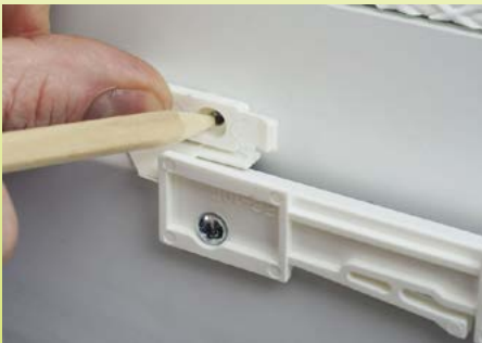
Abb. 5: Position der Schrauben für Fensterrahmen-Halterung markieren
