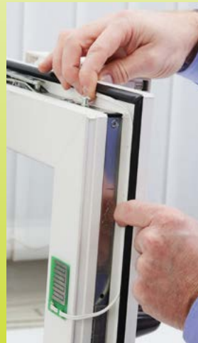
Abb. 31: Kabel seitwärts legen und mit Klebeband fixieren
