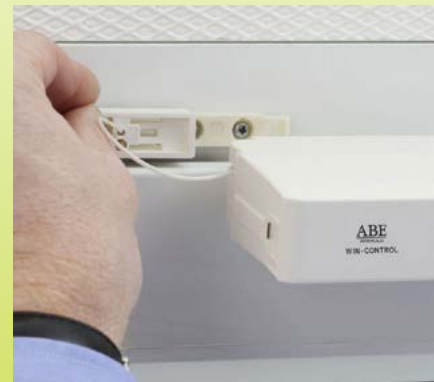
Abb. 36: Entfernen des Clip (A1)
