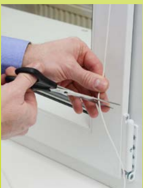
Abb. 19: Kürzen der Entriegelungsschnur auf die gewünschte Länge
