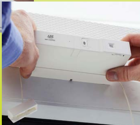
Abb. 10/11: Verbinden des Fensterschließers mit der Fensterflügel-Halterung
