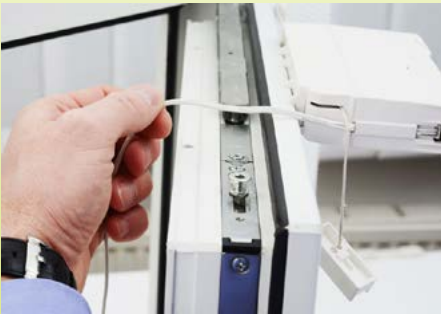
Abb. 23: Führen des Kabels nach außen
