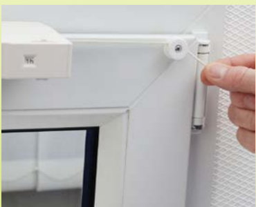
Abb. 17/18: Entriegelungsschnur über die Umlenk-rolle legen und deren Abdeckung darauf setzen
