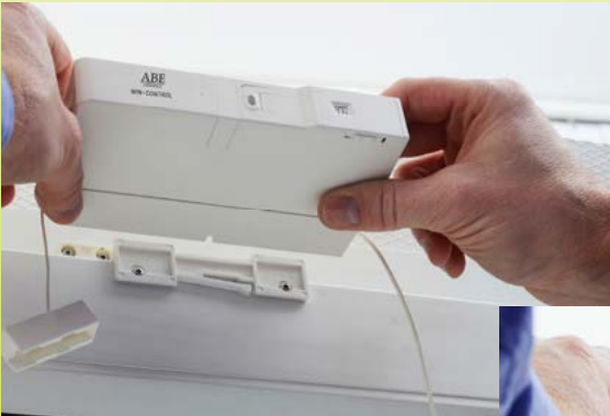
Abb. 10/11: Verbinden des Fensterschließers mit der Fensterflügel-Halterung
