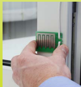
Abb. 25: Regensensor befestigen
