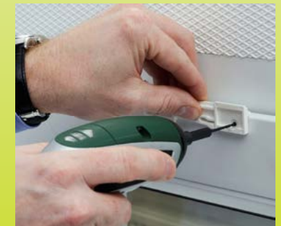
Abb. 2: Löcher am Fensterflügel vorbohren
